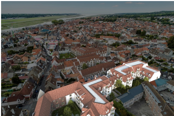
Vue de la future résidence d'Etaples-sur Mer
